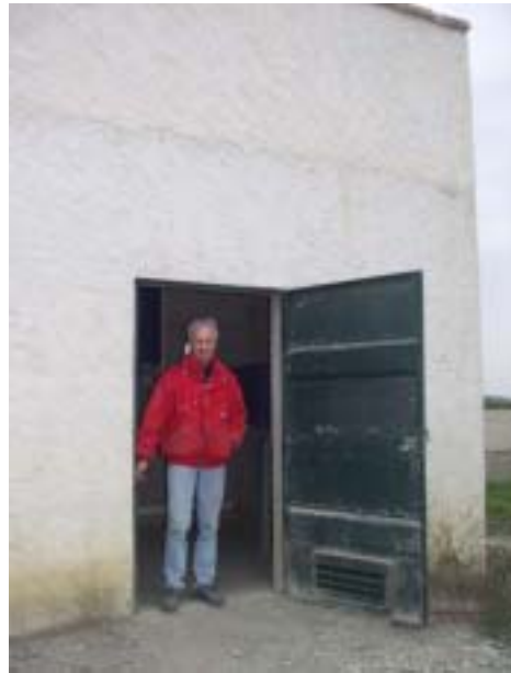
station rehaussée pour mise hors d'eau
