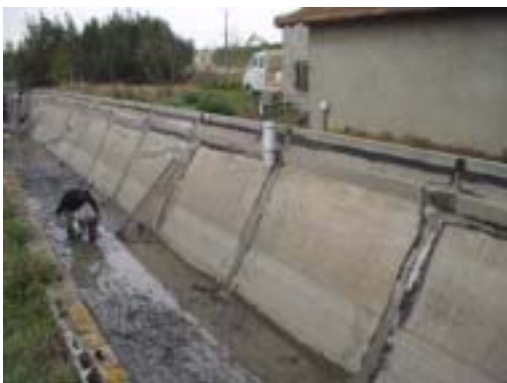
travaux de maçonnerie
