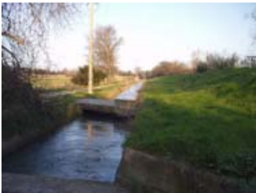
Canal en béton au début + envoi d'eau 1 fois par semaine en hiver
