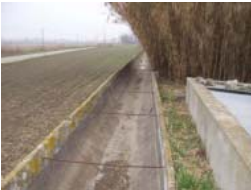
partie du canal en état correct
