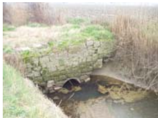
Pont fragilisé
