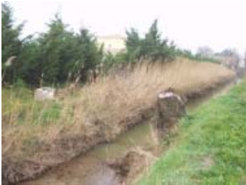
Construction nouvelle - plus de piste d'entretien
