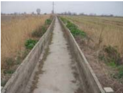
Canal principal St Césaire réhabilité
