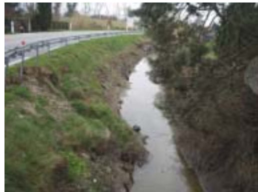
éboulement de la roubine d'irrigation
