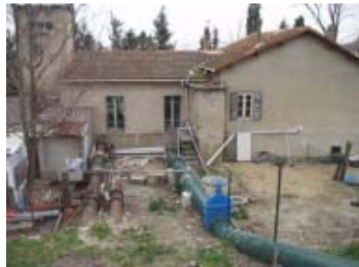
Station Saliers (nouvelle conduite)
