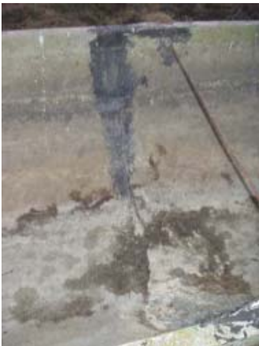
Colmatage canal au goudron
