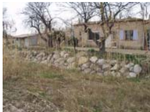
Enrochement de protection des maisons
