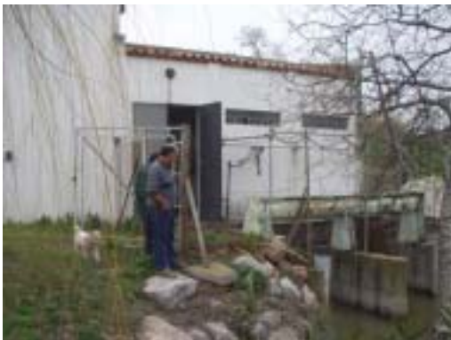
Extérieur station avec dégrilleur
