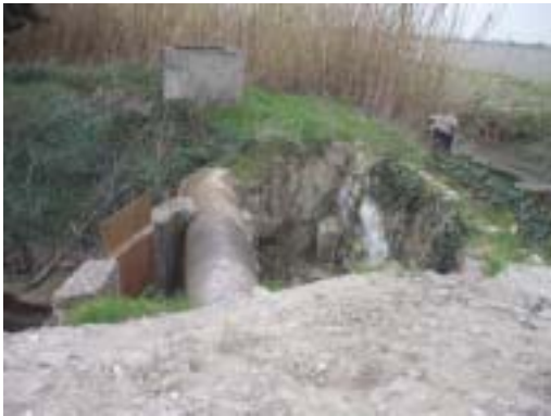
conduite croisant roubine d'assainissement
