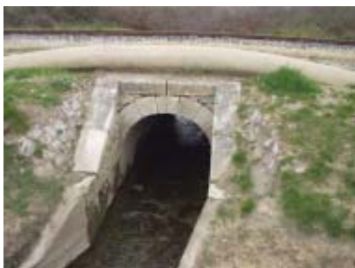
Passage calibrée sous la voie de chemin de fer (route de St Gilles)
