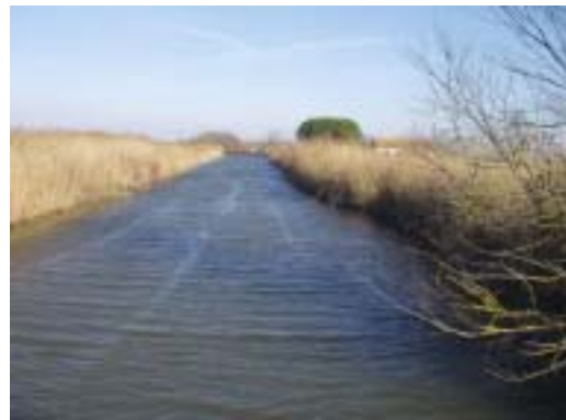
Canal Fumemorte vers les Marquises
