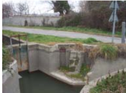
Ouvrage de répartition hameau de Gimeaux
