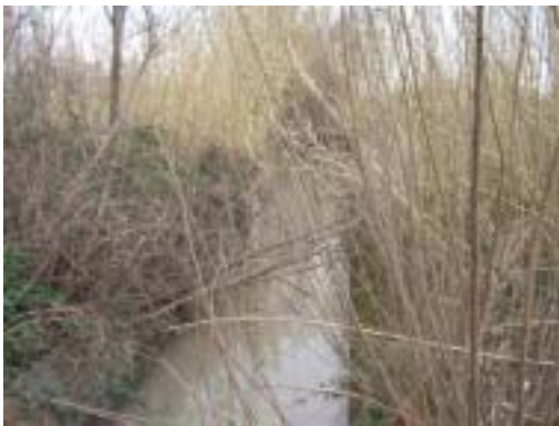
Canal en terre
