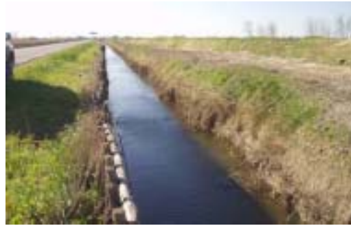
Fascinage et protection de berge (début D37)
