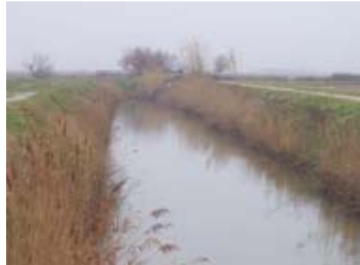
Fin de l'égout des Saliers
