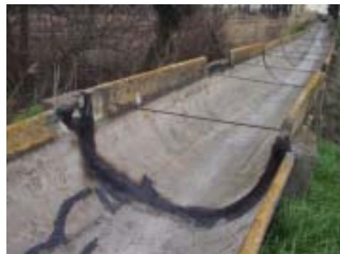
mouvement et écart du canal
