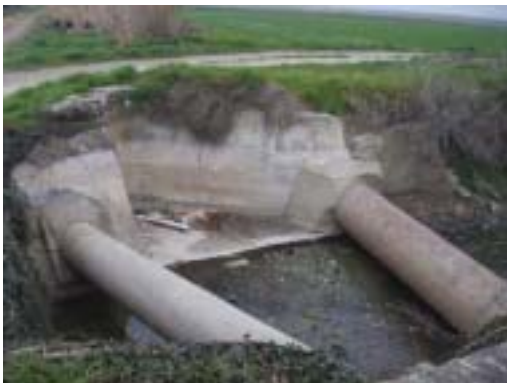
conduite croisant roubine d'assainissement
