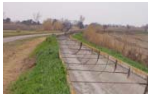
basculement du canal
