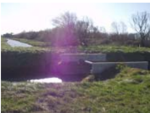
Croisement canal d'irrigation - canal d'assainissement
