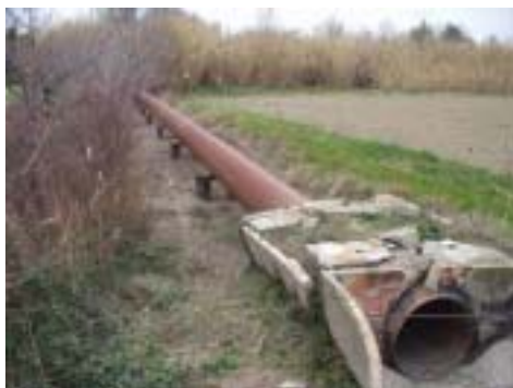
canal Sambuc - refait sur 200m en acier
