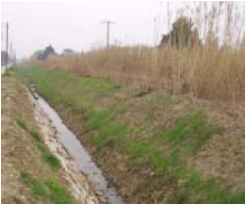
Enrochement début canal
