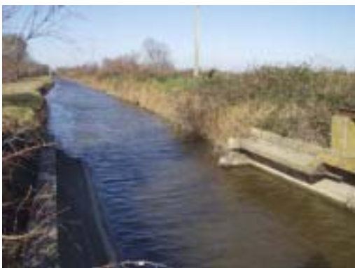
Vedeau - Canal principal
